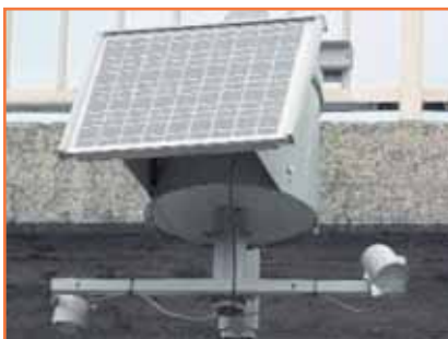
30. ábra. Napelem táplálású detektor a DDG adatgyűjtő hálózatában. Az adatok központ felé való továbbítása GSM hálózaton történik
