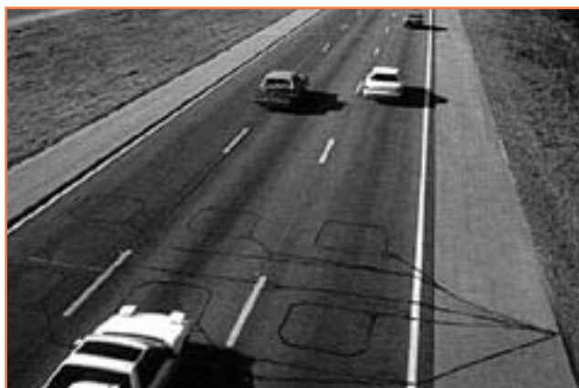
9. ábra. Detektorhurkok háromsávú úton
