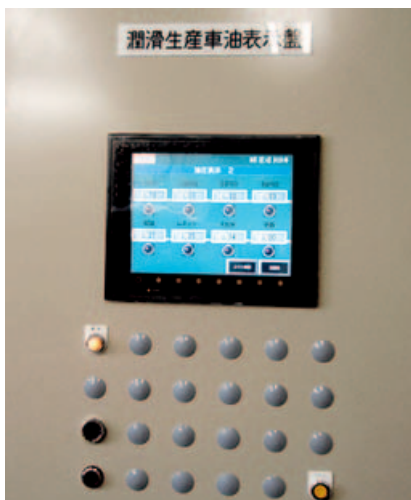
2. ábra. A MODBUS TCP-érintőpanel
