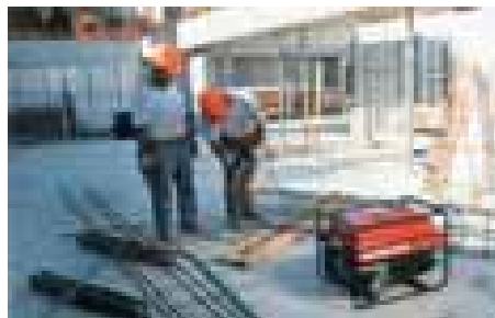
3. ábra. Hordozható áramfejlesztő terepi, építkezési munkákhoz
