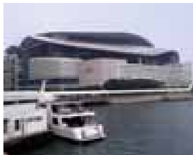
4. ábra. A Kongresszusi és Kiállítási Központ épülete
