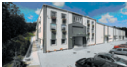
2. ábra. Az új üzem épülete
